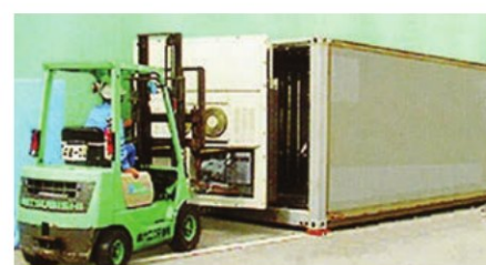
コンテナ設置シーン
