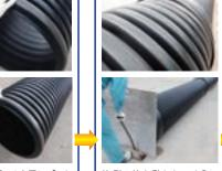
片側の管を動かないように 固定し、受口部の入るところ まで差口部を挿入する。その 後もう片側の管端部を保護 し、ゆっくり押し込む。 例) 管端部をコンパネで保護 し、バールを用いてテコの原 理で挿入(上図)
