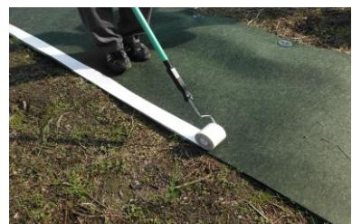
シートの重ね合わせ部分の下側にローラーを転がして貼り付け。
