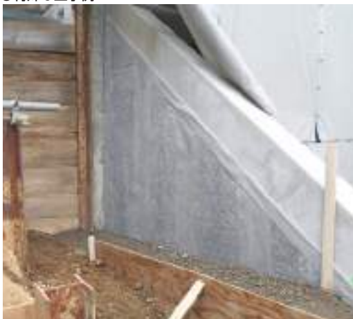
●特殊な工事例
