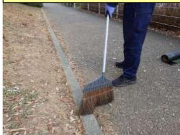
水分・砂・ホコリ等を完全に除去します。(除去が不完全ですとプライマーの性能が低下します。)
