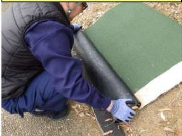
片面溶着タイプを使用の上、重ね合わせの位置にシートを展開し仮敷きします。
