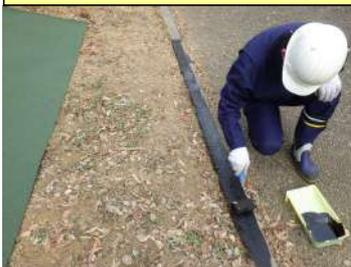
厚塗り・薄塗りに注意し、均一に専用プライマーを塗布した後、十分にプライマーを乾燥させてください。
