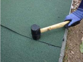
炙って裏面が溶けているうちに、ゴムハンマーやローラーなどで転圧をし、確実に密着させます。
