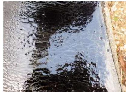
裏面のアスファルト層が溶け出したら冷え固まる前にすぐに接着面へ貼り合わせて転圧します。
