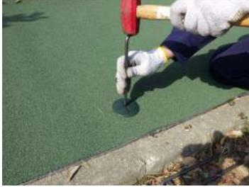
ワッシャーをセットし固定ピンを打設します。
