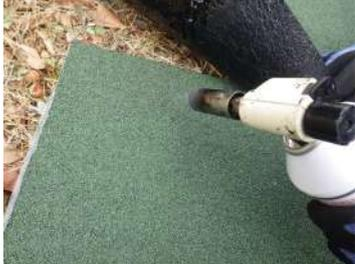
シートを 10cm 重ね合わせ、下側にくるシート表面の保護砂部分をバーナーで炙ります。
