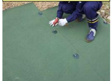
溶着箇所をハンマーやローラーで転圧後、重ね合わせ部の上から 50cm ピッチで固定ピンを打設します。
