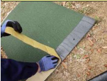
シート片側に固定ピンを打設し、剥離紙を剥がします。
