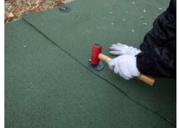
重ね合わせ部の上から 50cm ピッチで固定ピンを打設します。
