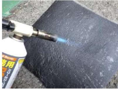
トーチ・バーナーを使用してフィルム層を完全に溶かし、アスファルト層が溶け出すまで炙ります。
